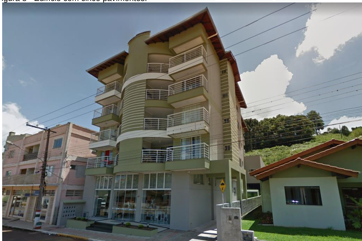
Figura 8 - Edifício com cinco pavimentos.
